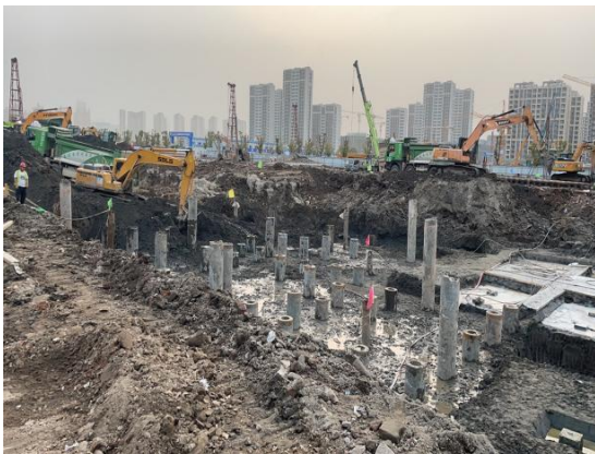
图 1.1-4 C 地块 9#楼施工进度情况
