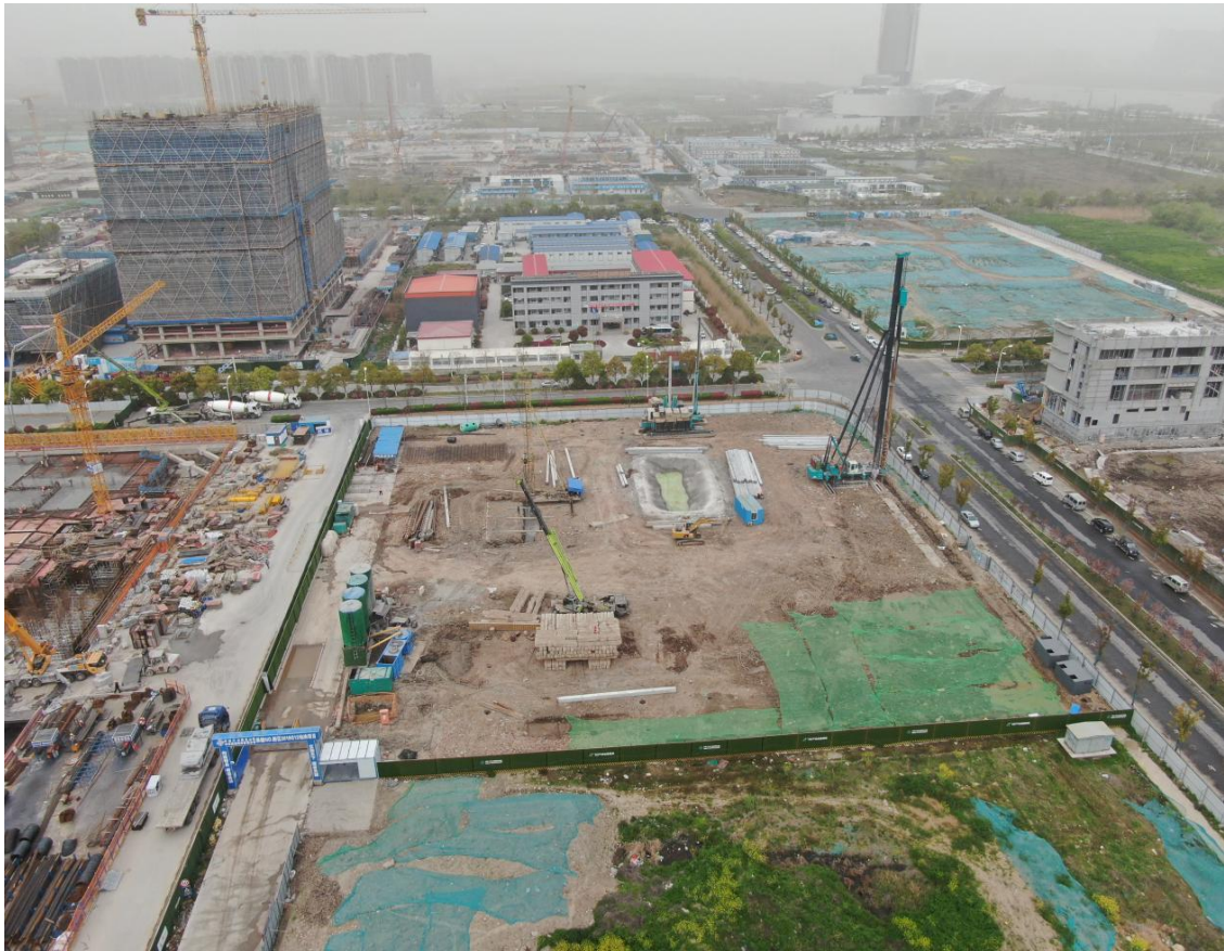
图 1.1-3 D 地块现状照片 (2021.3.30)
