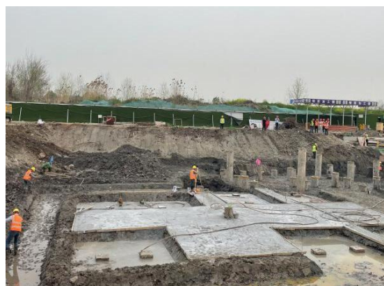
图 1.1-5 C 地块 7#楼施工进度情况
