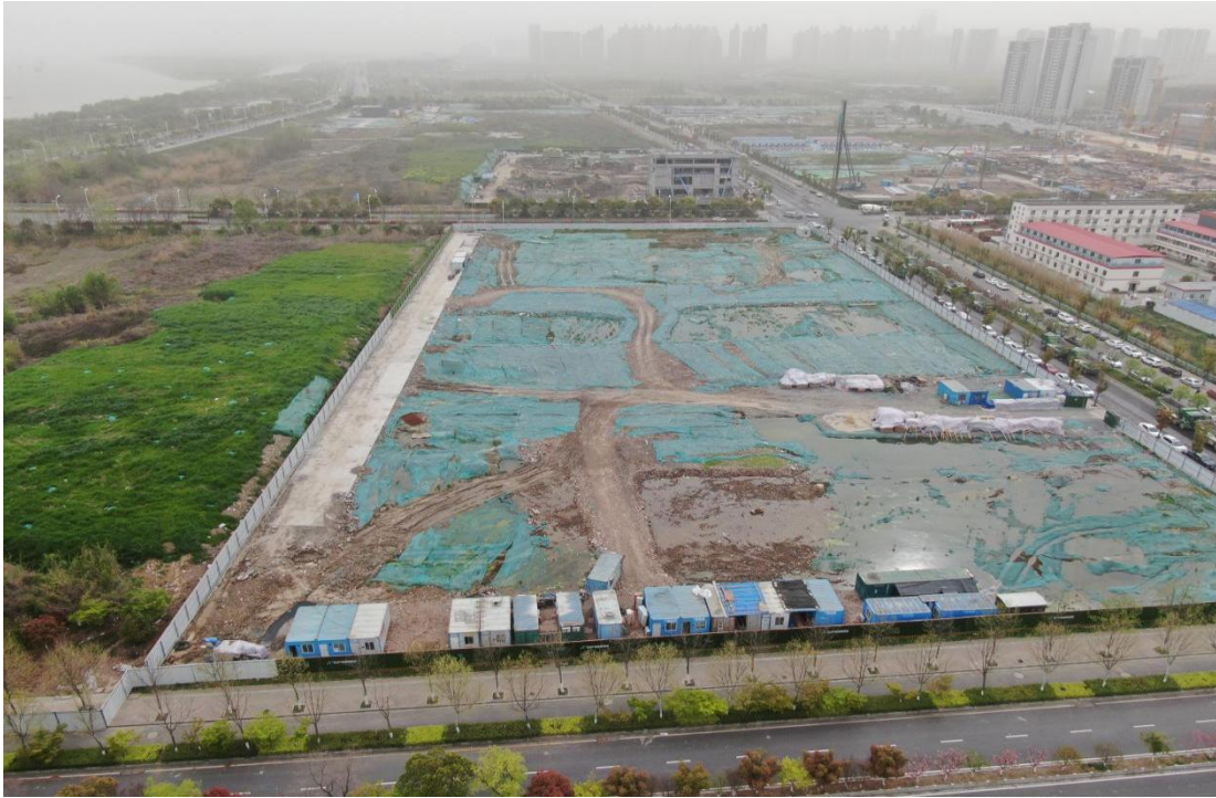
图 1.1-1 A、B 地块现状照片（2021.3.30）
