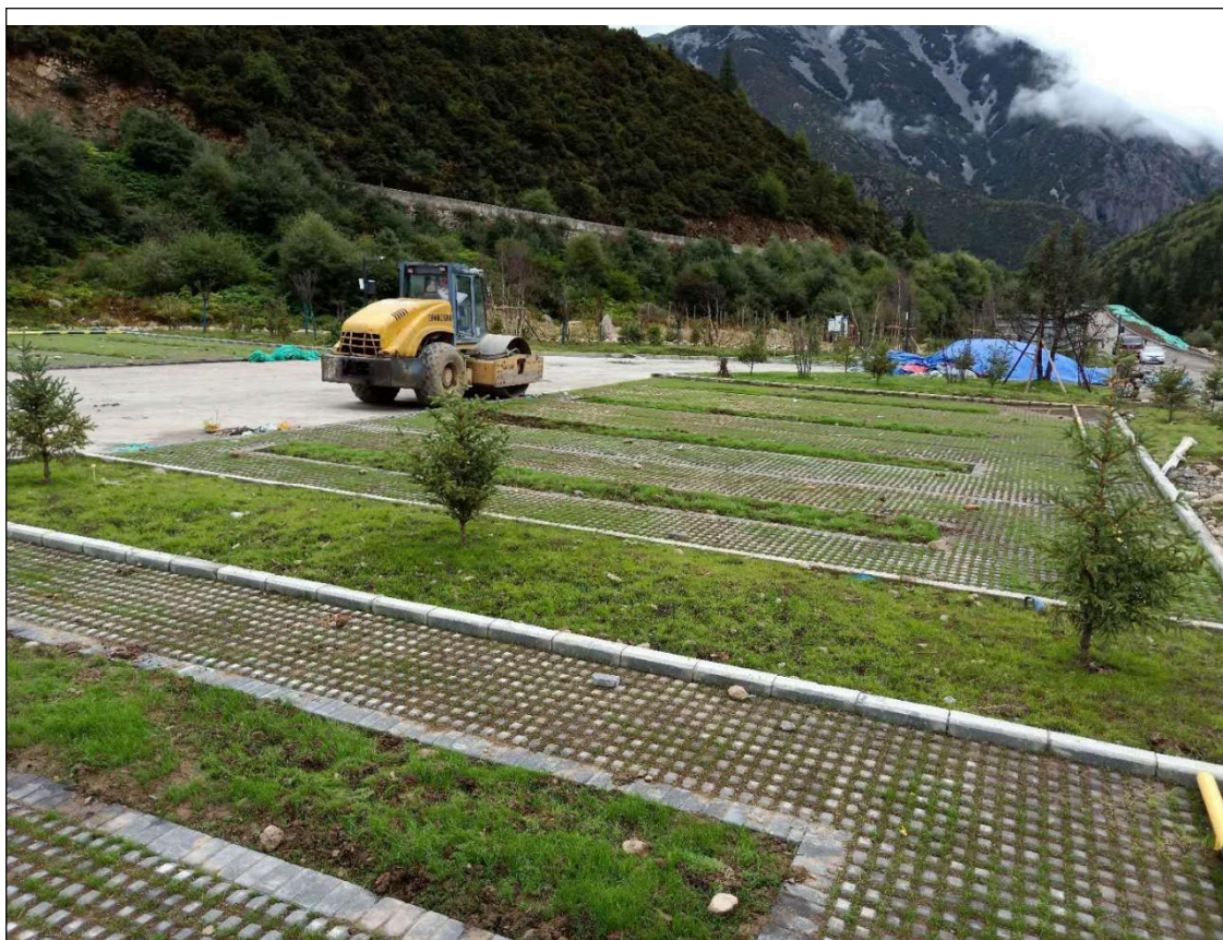
植草绿化、临时苫盖
