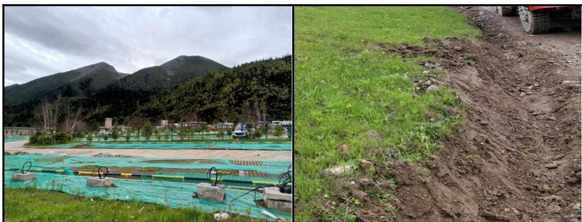
图 3.5-5 临时苫盖（2018 年 8-2020 年 9 月）临时排水沟（2018 年 8-2020 年 9 月）
