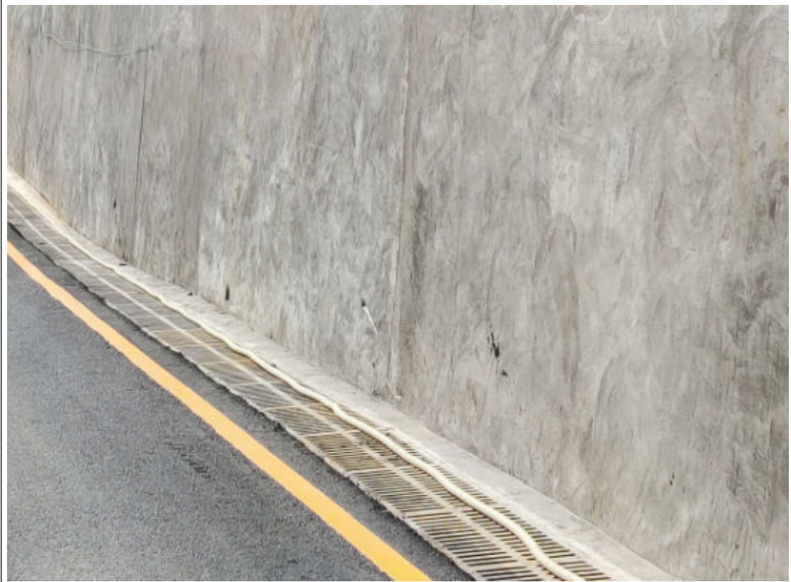
混凝土排水沟
