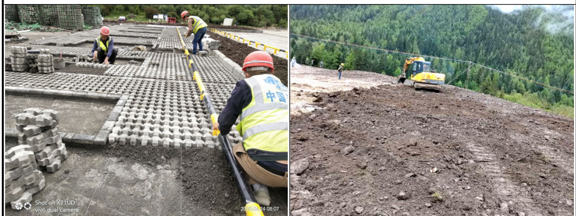
图 3.5-2 透水砖铺装（2020 年 5-9 月）、土地整理（2020 年 7-8 月）
