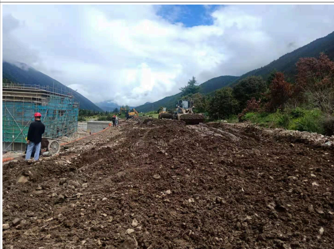
土地整治工程
