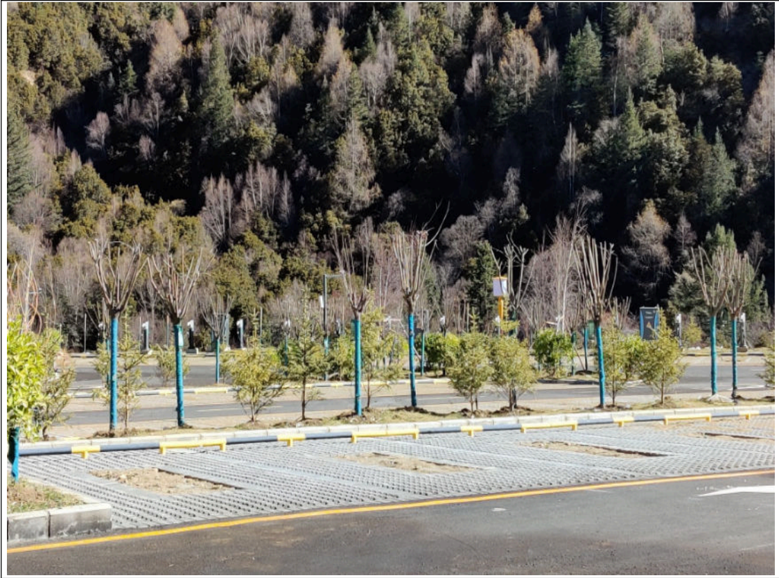
栽植乔灌、草坪，透水砖铺装
