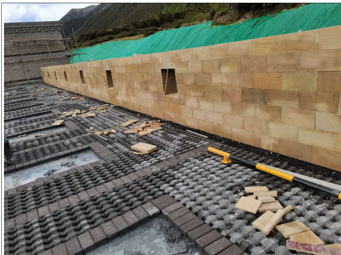
透水砖铺装、临时苫盖（过程中）
