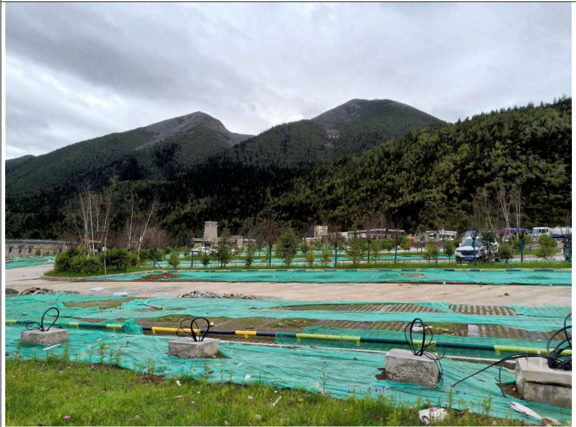
栽植草坪、透水砖铺装、临时苫盖
