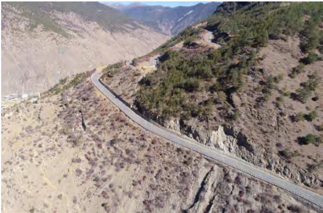
沿线路基情况
