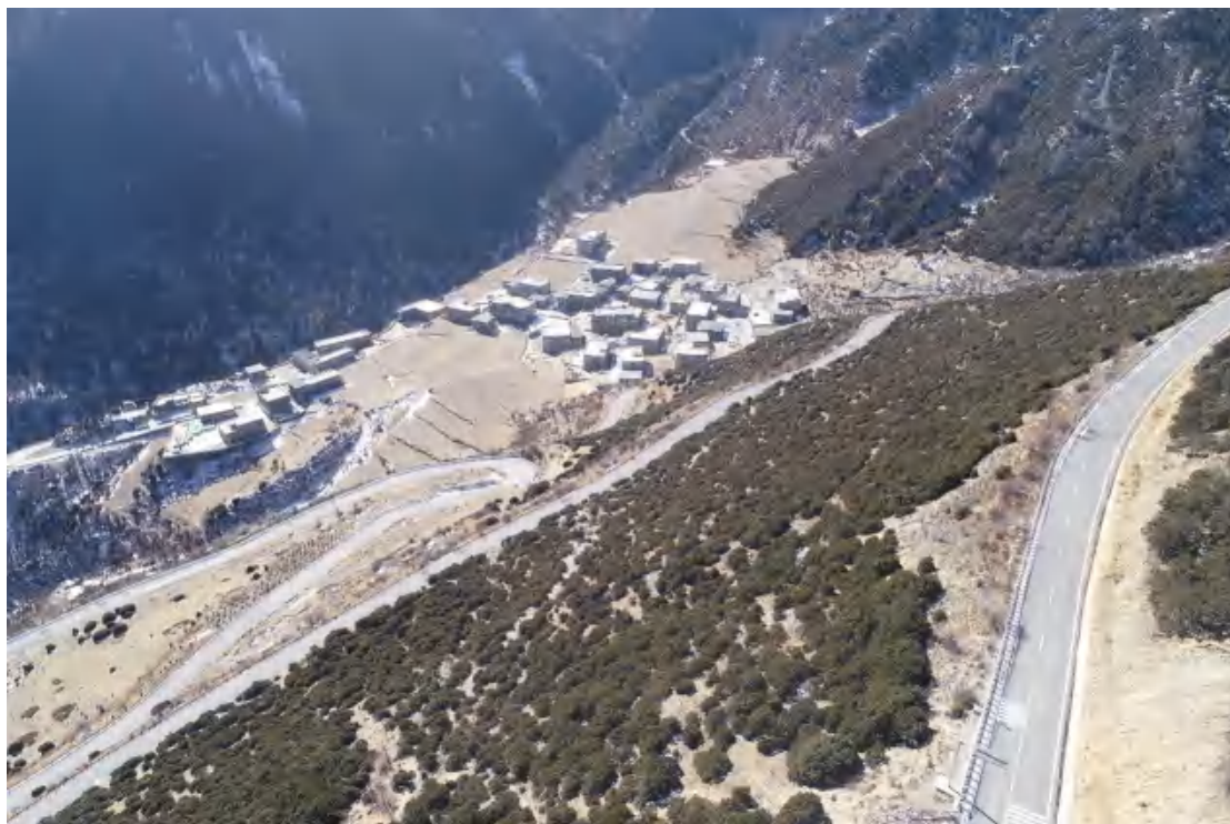
3#回顾性监测点布设 (K32+220 附近挖方边坡)
