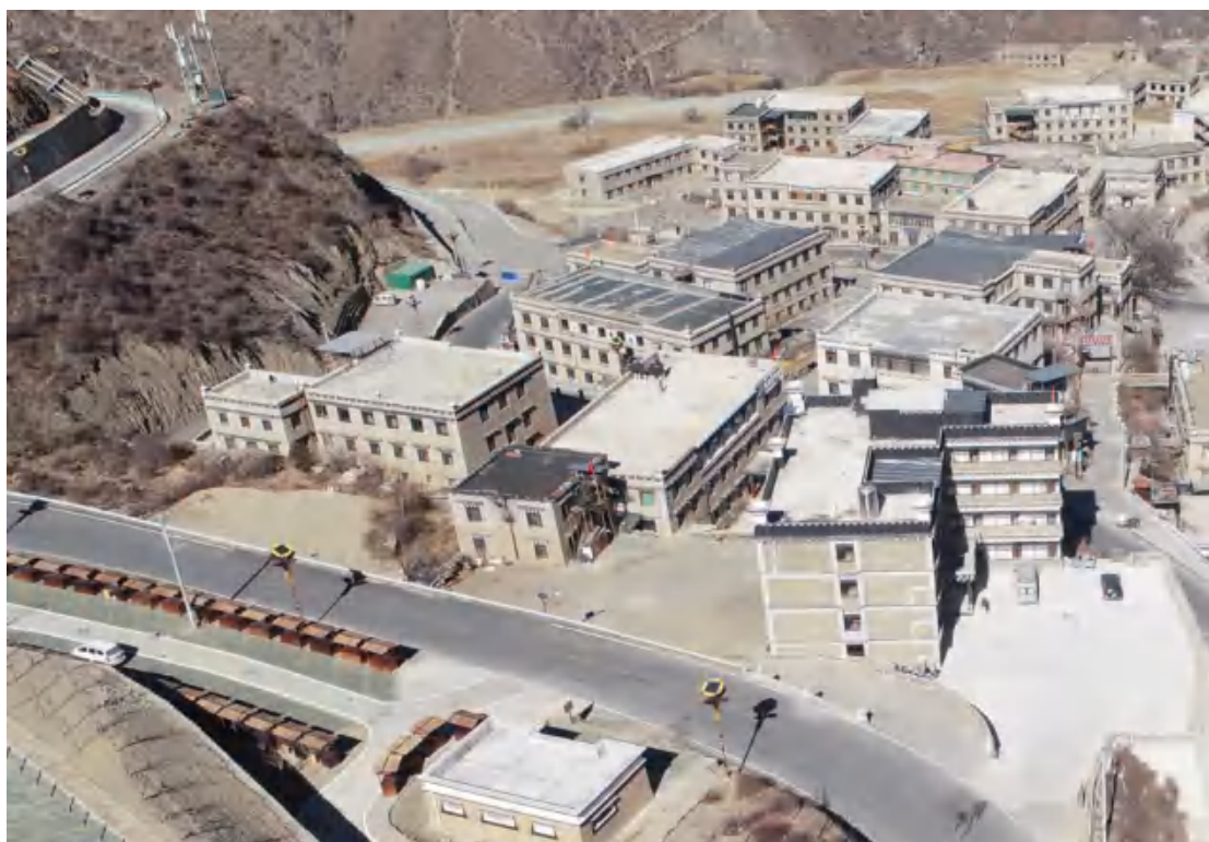
4#回顾性监测点布设 (施工工区现状)
