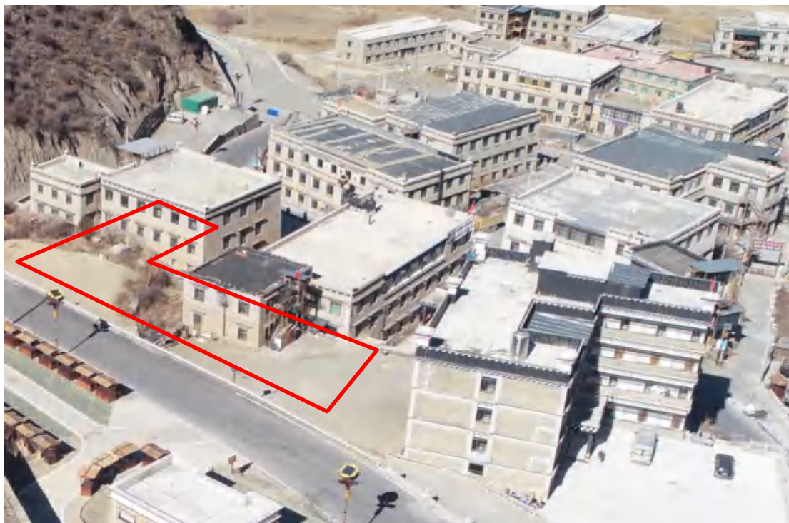
图 1-1 施工工区现状情况
