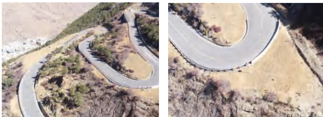
植被建设工程（1）
