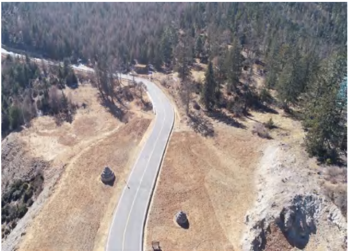
K15+000 附近路基、植被恢复等情况
