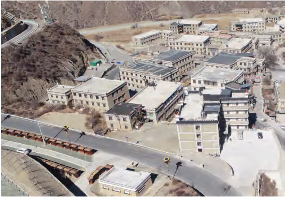
施工工区情况（现状已建成景区酒店等）
