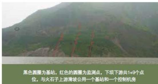
图2-1 下坝下游滑坡布点图
