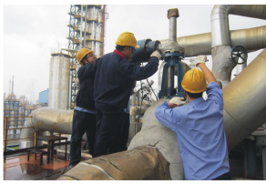
焦化A塔溢流阀检修现场
