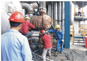
顶循燃料气换热器管束更换施工现场
