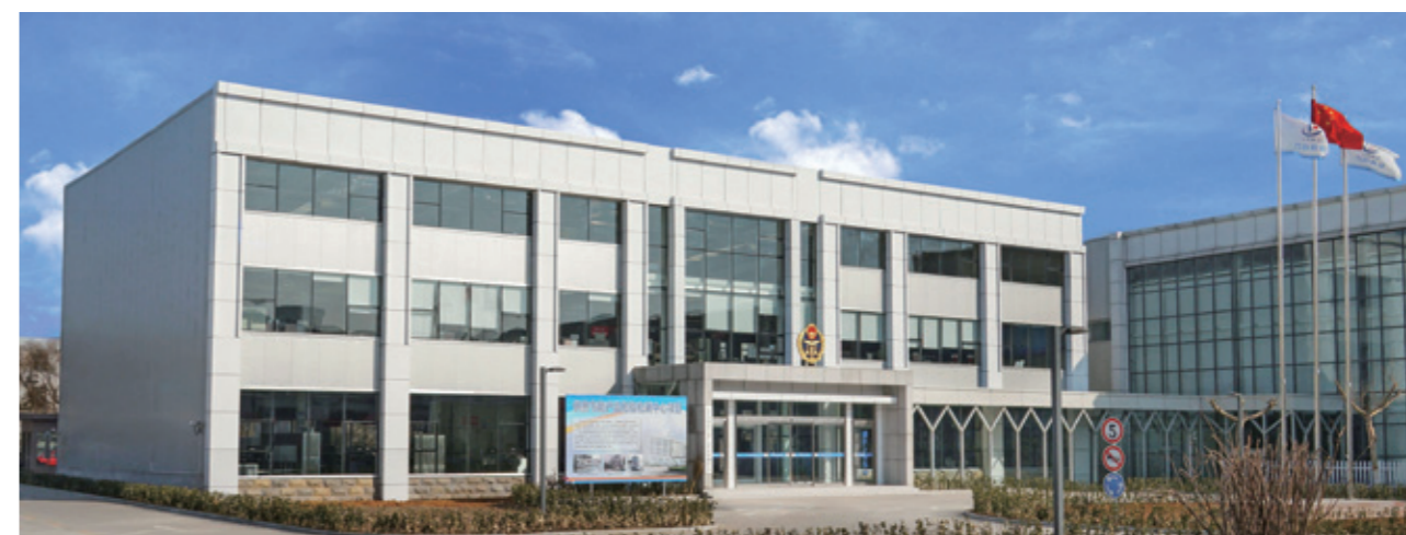
供热节能产品检验检测中心
