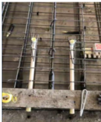
图 6 预埋管的预制墙板
