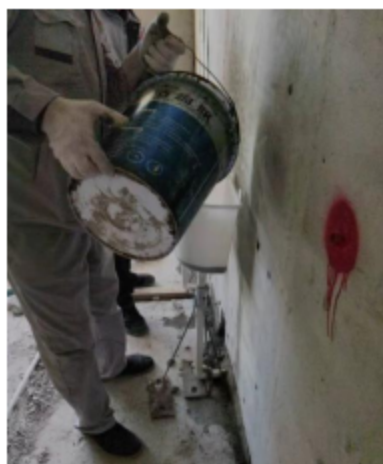
图 2 微压充浆施工
