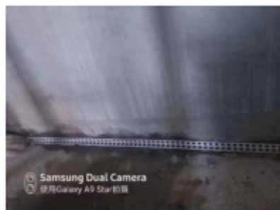
图 5 模板加砂浆封仓
