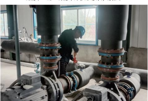
供热站房保压试验进行管网查漏
