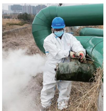
供热三科检修人员对蒸汽管道进行暖管、疏水工作
