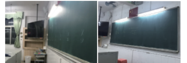
黑板灯安装不合理，非但不能使学生看清黑板，反而加重了黑板的漫反射和明暗对比度，给学生眼睛造成二次眼疲劳，加重学生眼睛使用负担
