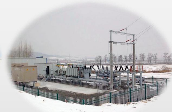
施工电源、技改工程用 可移动式E-House
