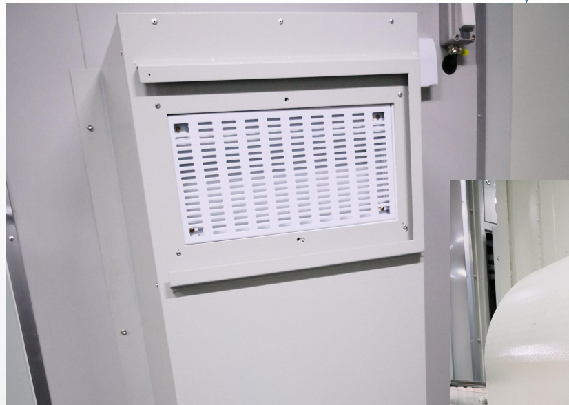
安装余压阀的出风口
