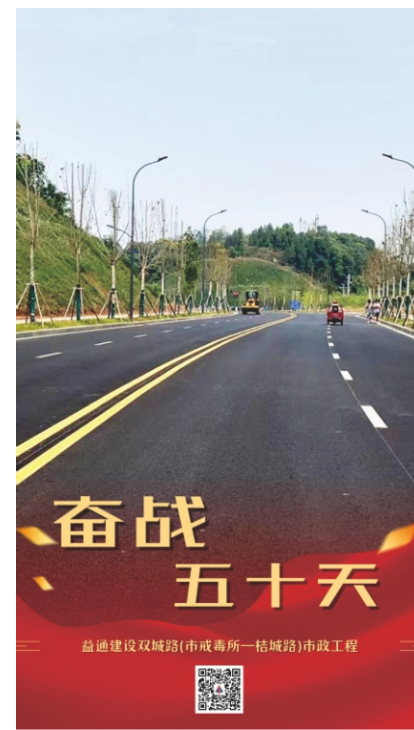
双城路(市戒毒所—桔城路)市政工程
