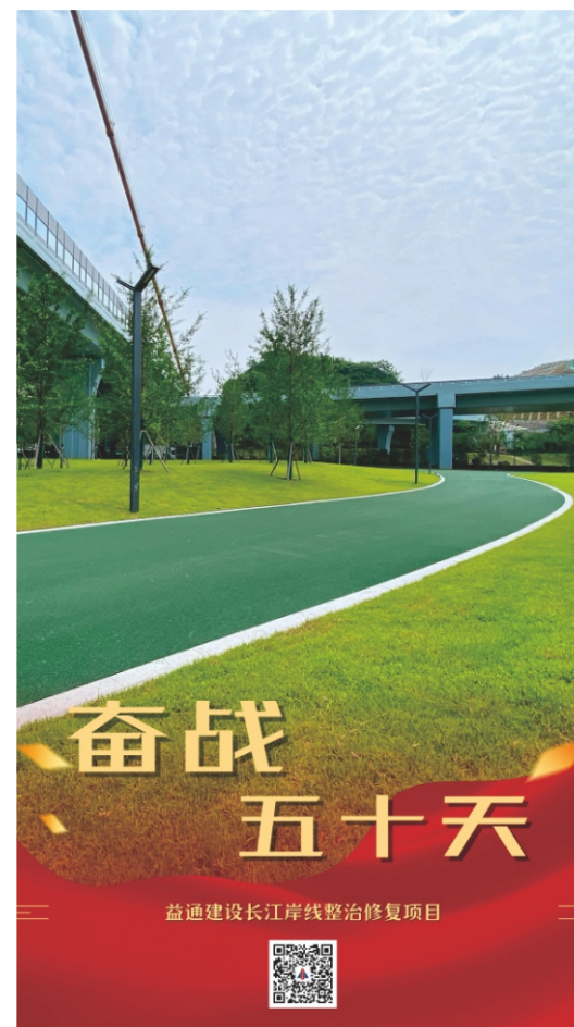
长江岸线整治修复项目
