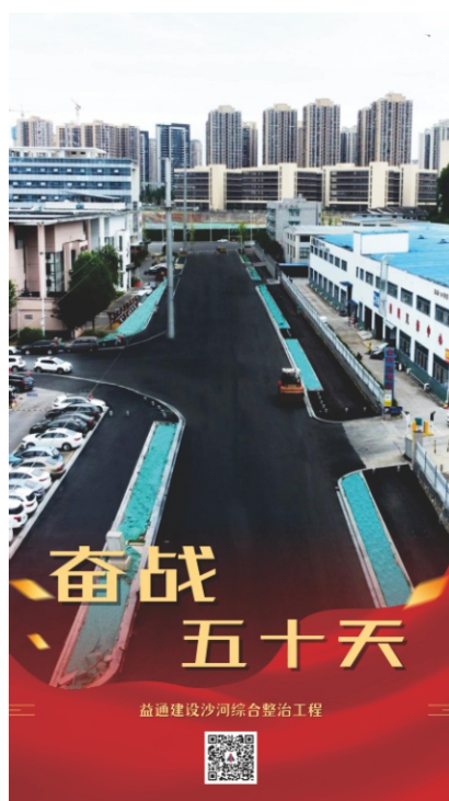
沙河综合整治工程
