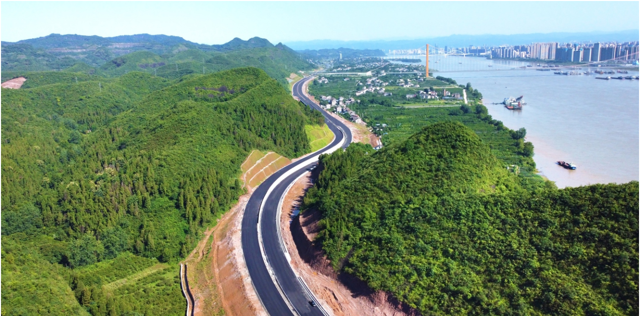
宜昌市江城大道下段（伍家岗长江大桥—仙人桥）项目
