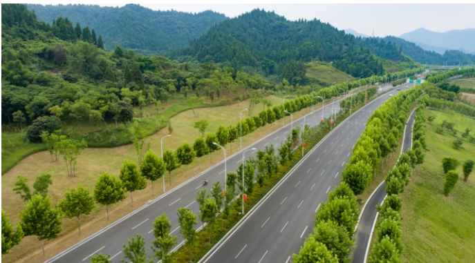
宜昌市夷桥路快速化改造工程
