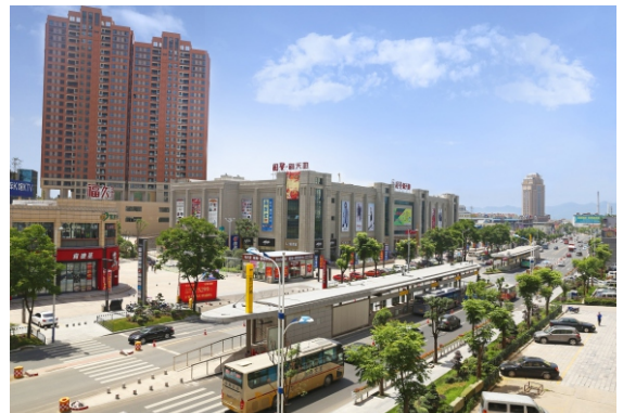
宜昌市BRT桔城路
