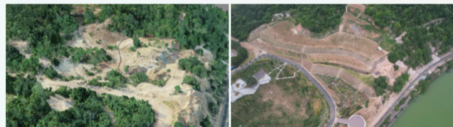
施工前原貌图
