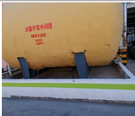
罐区围堰倒流沟
