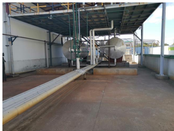
罐区地面硬化
