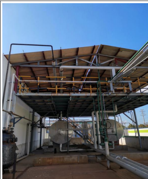
氟化氢罐区顶棚
