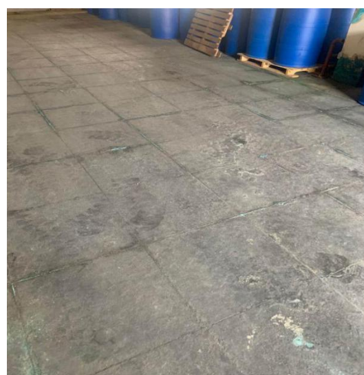
危险品库地面防腐
