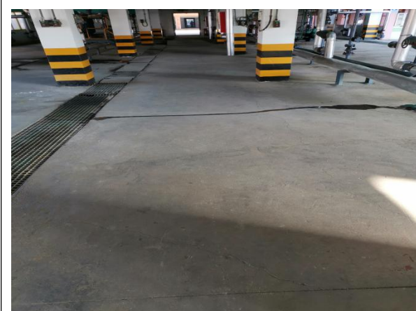
车间地面硬化
