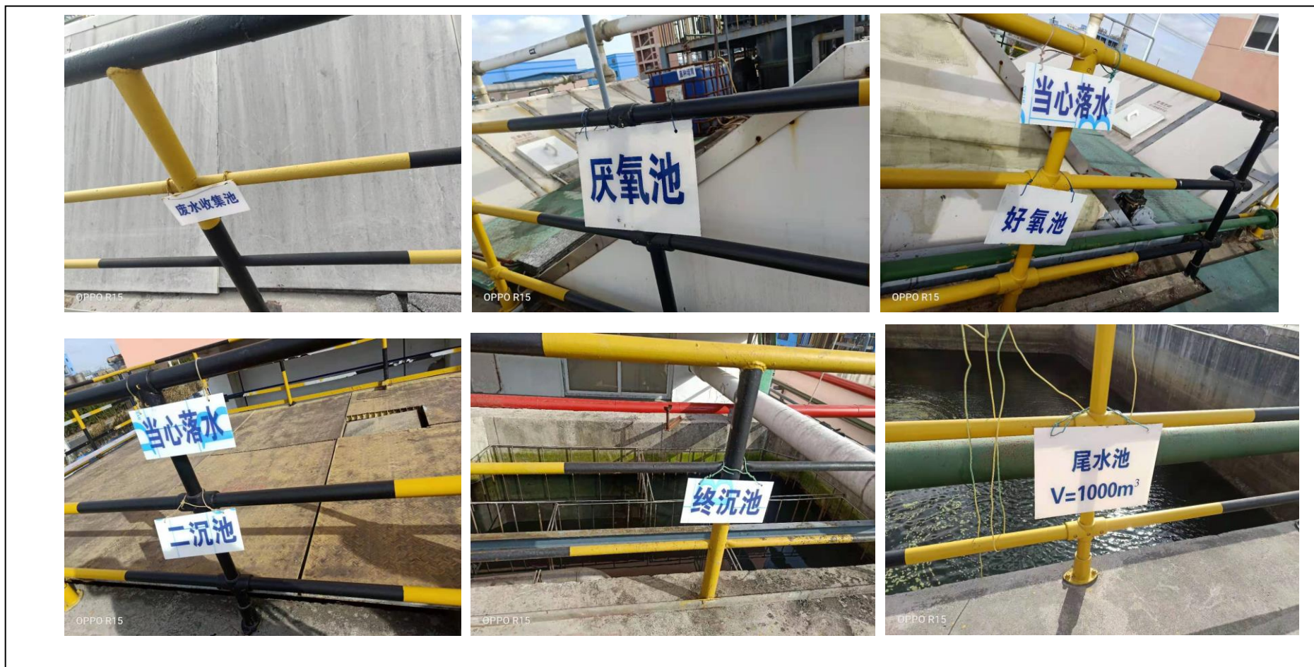
图 3.2.4-6 厂区综合污水处理站现状
