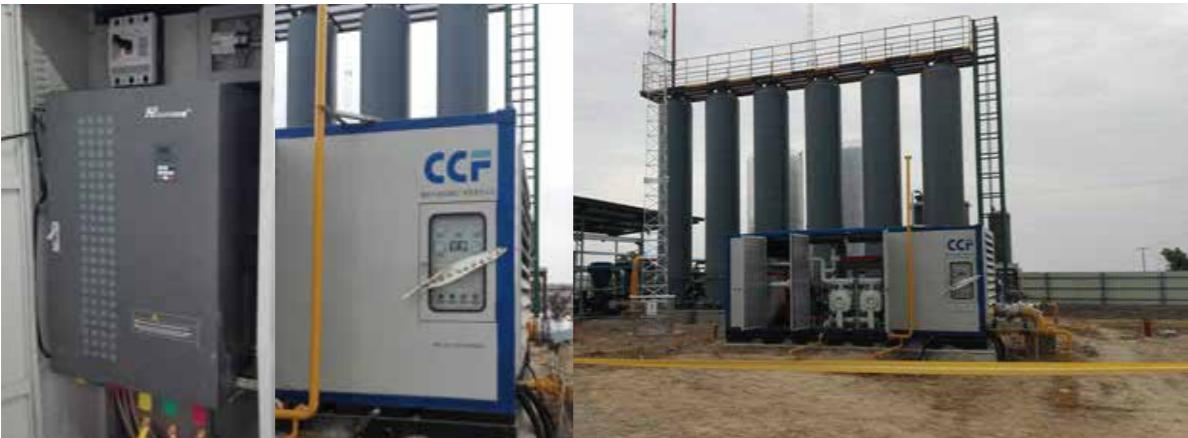
280KW变频器在压缩机上的应用
