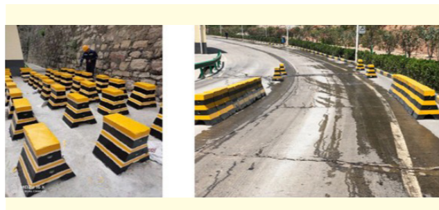
【运行保障部制作隔离墩，用于厂内车辆限速】
