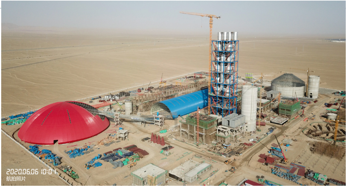
“沙漠之星”火热建设现场
