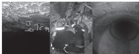
更换前下垂7cm 更换时支模 更换后情况
