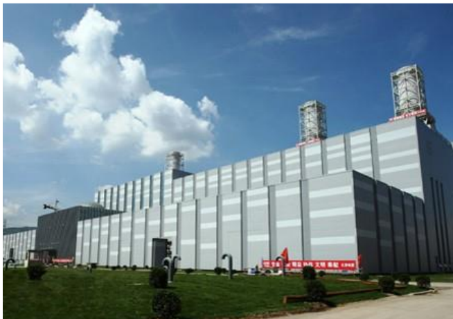
项目名称：华苑供热煤粉锅炉
