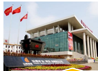
汾西矿业 煤粉蒸汽锅炉
