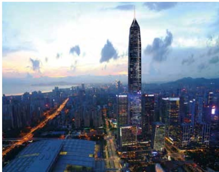
深圳平安金融中心项目于近日组织了首次三维可视化技术交底, 现场由图纸平面二维管理升级成三维多角度可视化模拟管理, 同时对复杂节点进行了可视化多角度交底, 让方案交底具有更强的针对性、全面性和可操作性。
