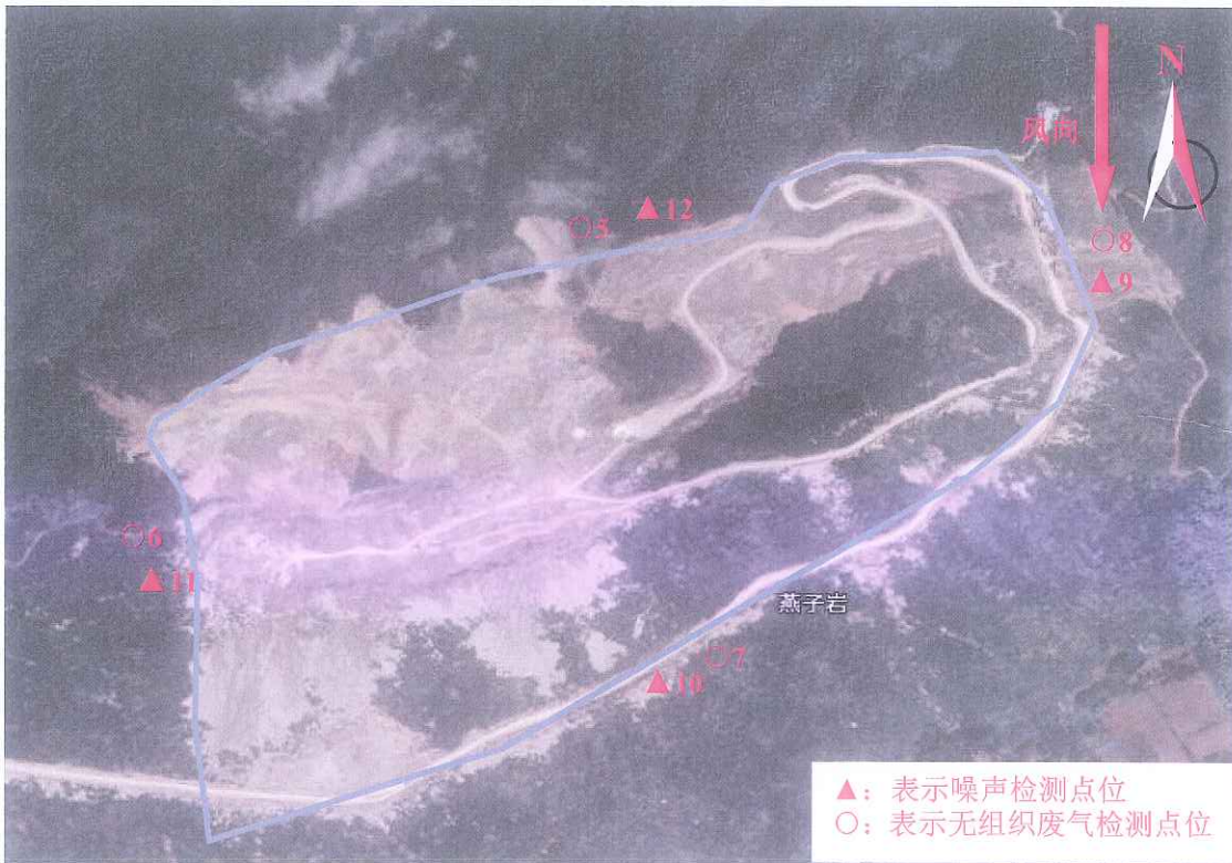
附图 3 江西万年青水泥股份有限公司万年水泥厂 2023 年度第一季度自行监测点位图 (石灰石矿区、鹅岭石灰石矿区)
