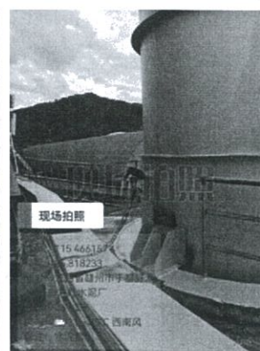
水泥磨废气排放口◎4
