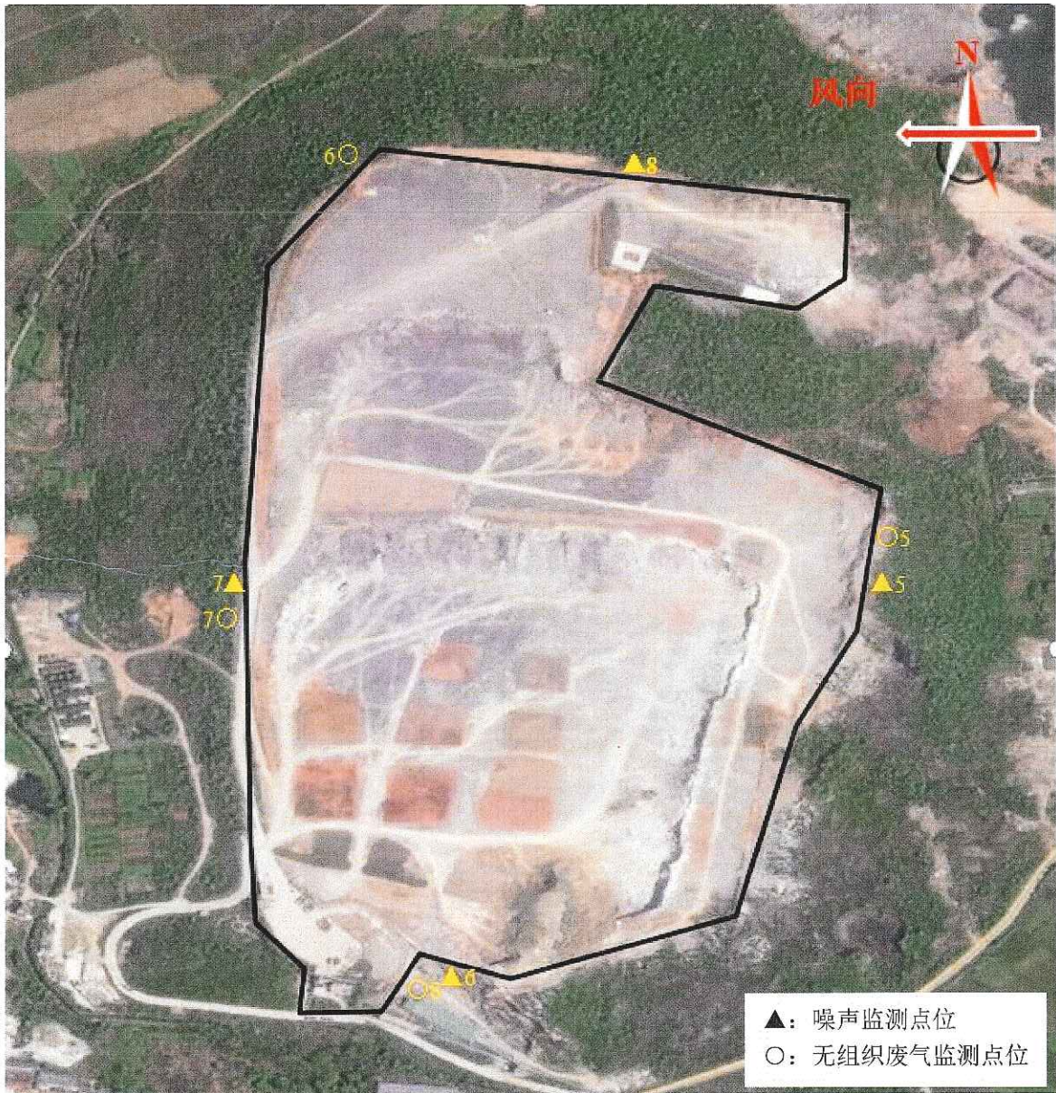
附图六 江西玉山万年青水泥有限公司 2023 年第二季度环境自行监测 检测点位示意图（后背山矿山）
