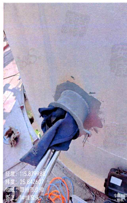
1#窑头废气排放监测口
