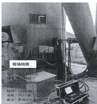
分解炉废气排放口#1◎4
