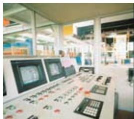
电站管理 和机舱监测报警、 主机遥控系统 PMS and Integrated Ship Monitoring & Control System
