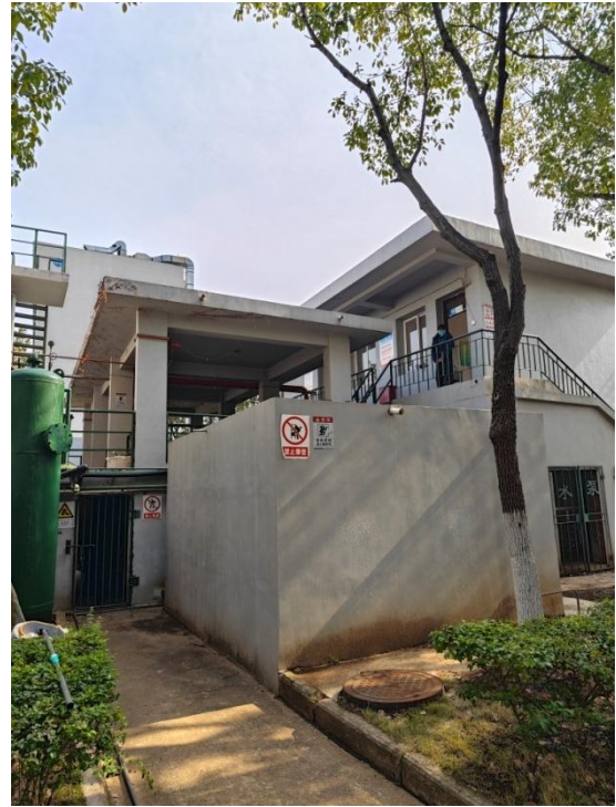
污水处理站操作间
