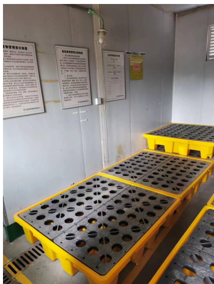
危险废物管理制度、防泄漏托盘及导流沟
