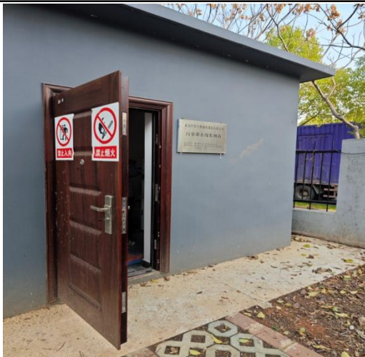
厂区污水处理站在线监测站房
