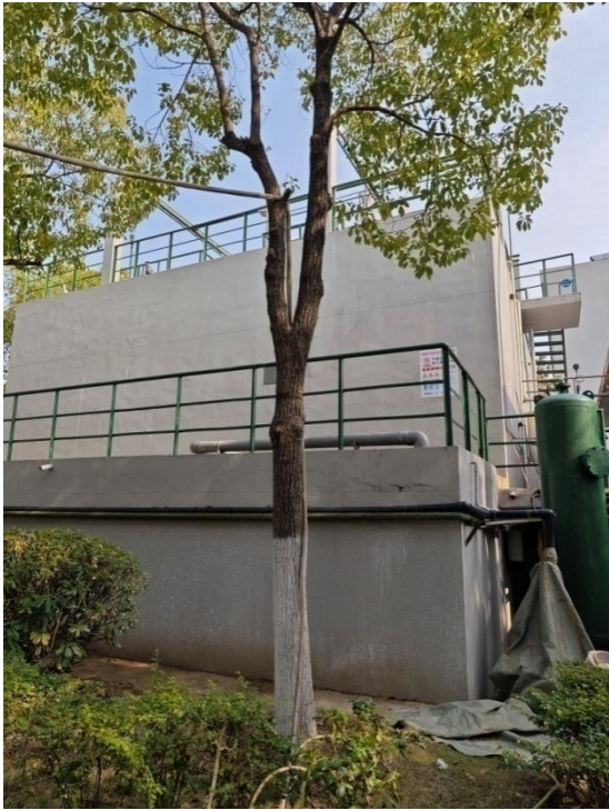
厂区污水处理站
