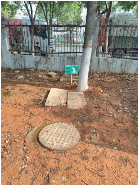
废水总排口 (DW001)
