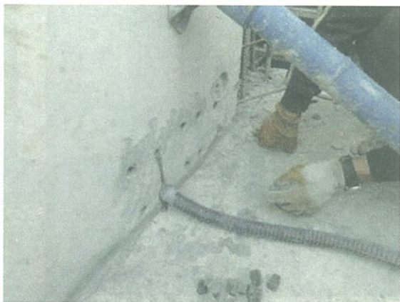
⑦ 灌浆区灌浆
