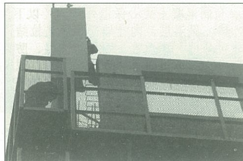
PCF板安装现场
