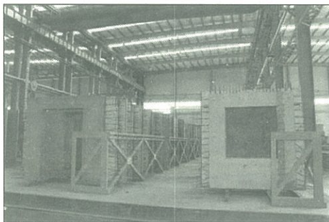
夹心外墙板存放
