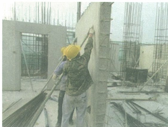
④ 墙板支撑安装
