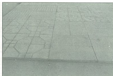
预制地板（现场临设）
