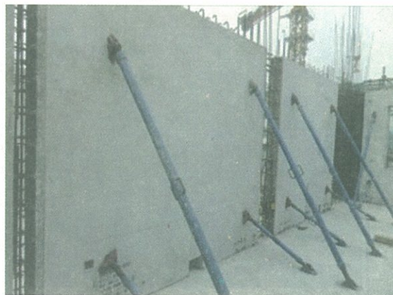
⑧ 墙体安装完成
