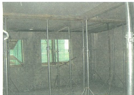
② 叠合板下工具支撑布置
