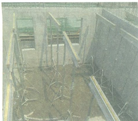
① 叠合板下支撑安装
