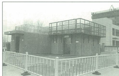
夹心外墙板样板
