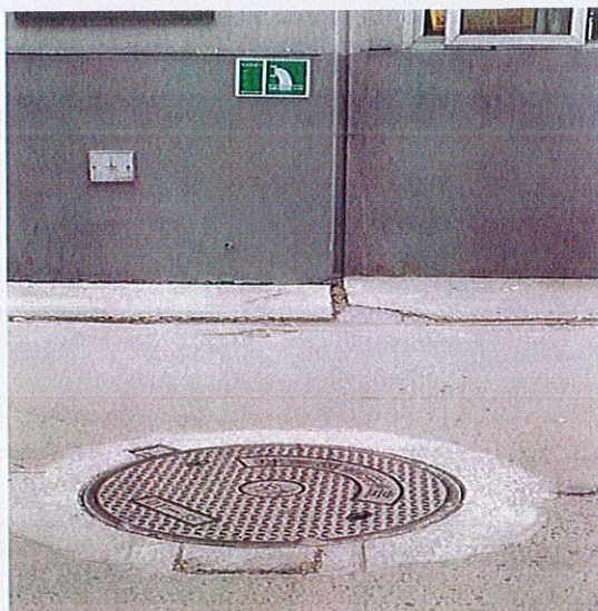
图 4.1-2 废水排放口环保标识牌
