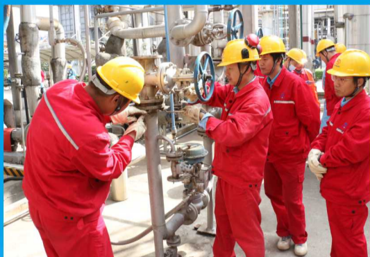
催化车间组织开展盲板抽堵技能比武
