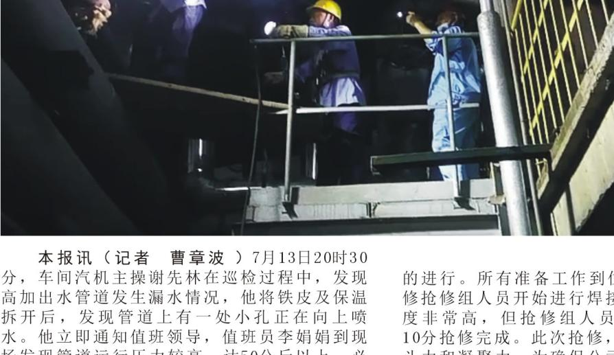
漏组人员陆续赶到现场。管道漏点随着时间推移,水量越来越大,王森副总经理一边组织当班人员将压力降到最低,保证设备安全,一边仔细观察现场,组织作业人员用螺帽套在漏点上进行焊接,然后用螺栓上紧。
