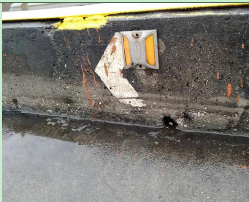
码头雨水收集口
