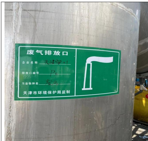
排气筒 P5 标识牌
