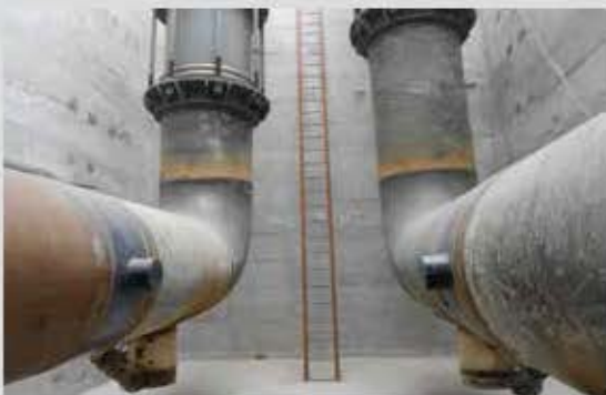
北京热力集团四大热电中心DN1400管线及支线阀门(2013-2015年)
