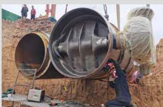
郑州热力集团“引热入郑”供热工程DN600-DN1600焊接蝶阀(2019-2020年)
