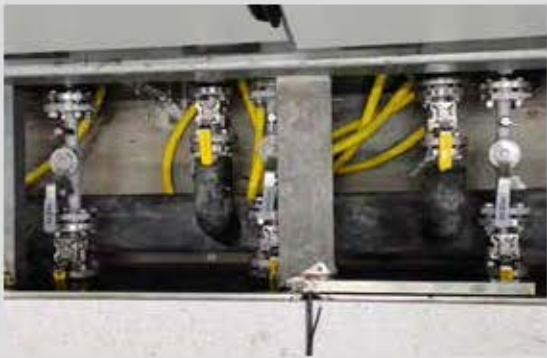
合肥离子医学中心质子加速器冷却系统用平衡阀
