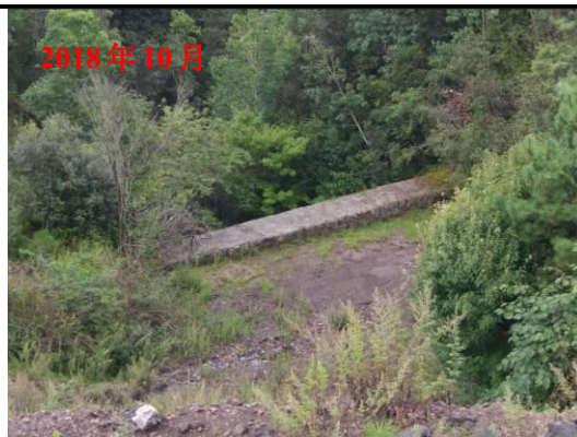
2#弃渣场对比情况
