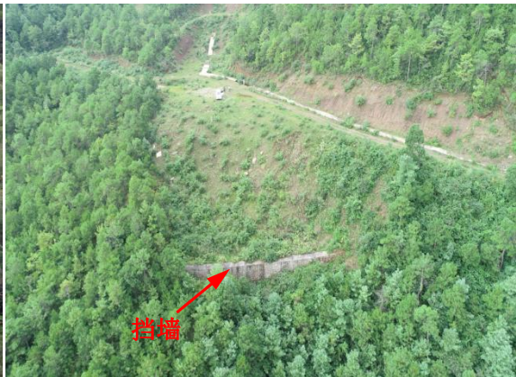
4#弃渣场挡墙及绿化现状（2018年10月）
