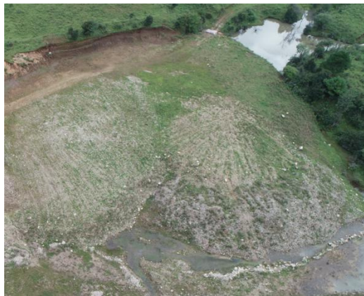
1#弃渣场绿化现状（2018年10月）
