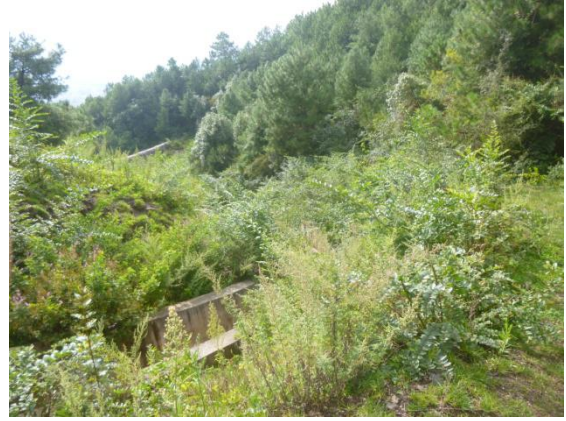
渠道绿化现状（2018年10月）
