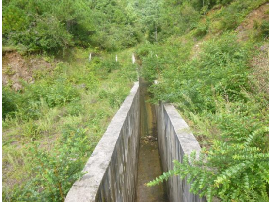
渠道绿化现状（2018年10月）
