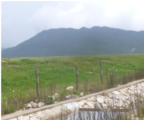
坝坡绿化现状现状（2018年10月）
