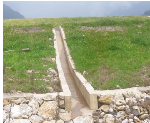
坝坡截水沟现状现状（2018年10月）
