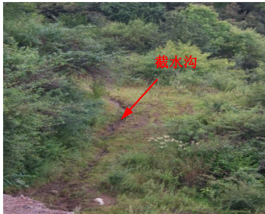
2#弃渣场截水沟现状（2018年10月）
