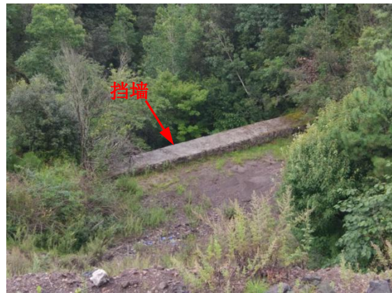
2#弃渣场挡墙及绿化现状（2018年10月）
