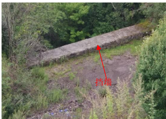
2#弃渣场挡墙及绿化现状
