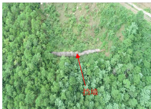
3#弃渣场（原 4#弃渣场）挡墙及绿化现状
