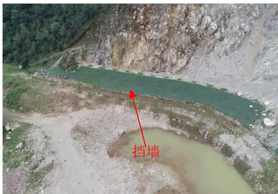
石料场拦挡及绿化现状
