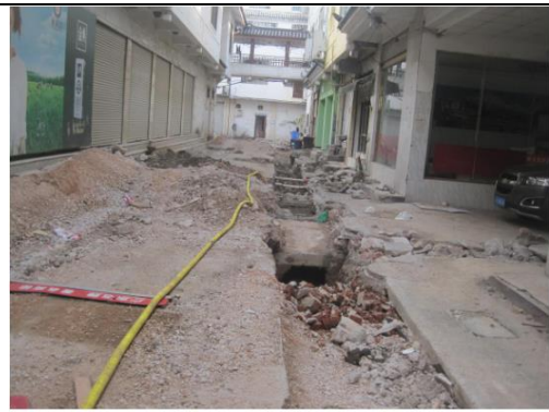
施工期开挖土石（2018年5月）
