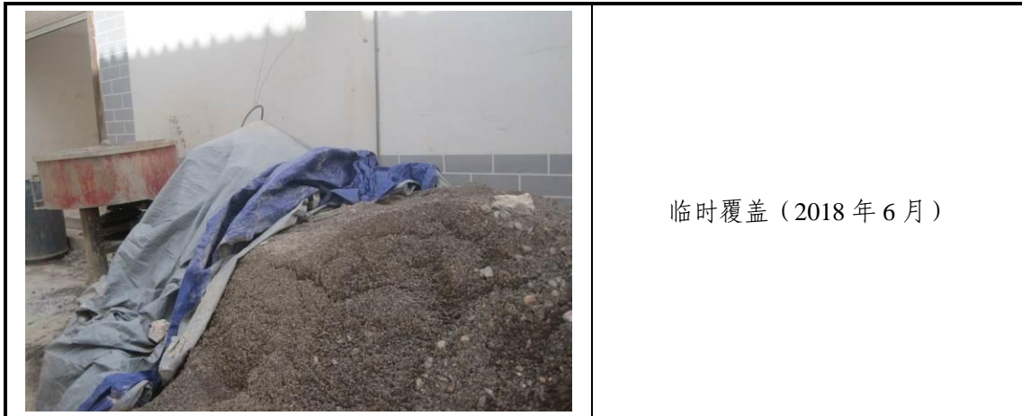
图 4-2 项目实施的临时措施
