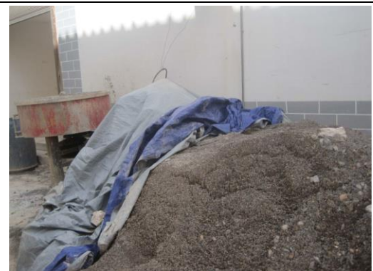
临时覆盖（2018年6月）
