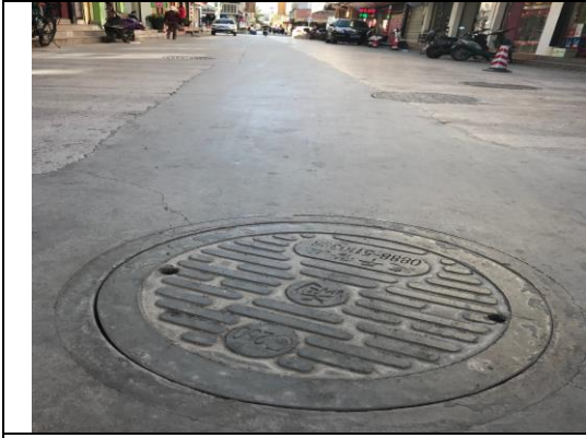
雨污水管现状（2018年10月）
