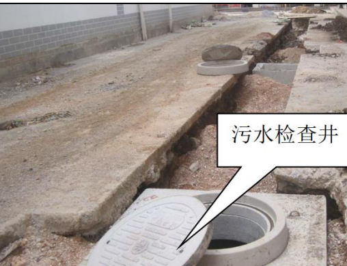
雨污水管埋设（2018年6月）
