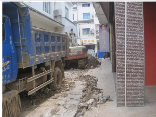
施工期土石清运（2018年5月）
