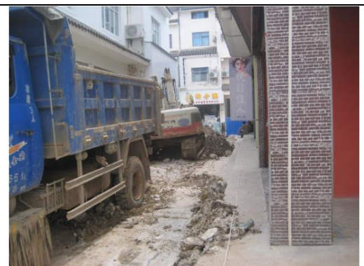
施工期土石清运 (2018年5月)
