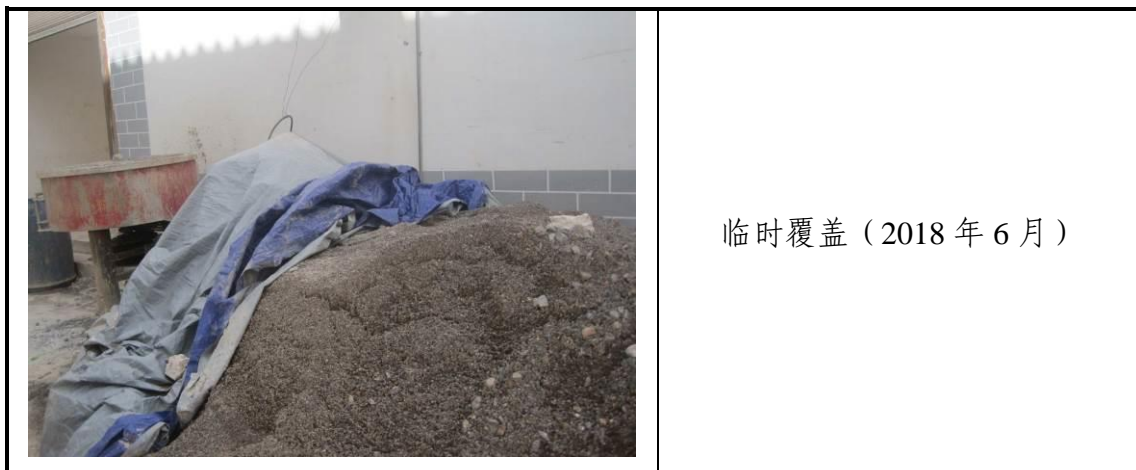
图 3-1 部分临时措施现场实施照片（摘自监测照片）
