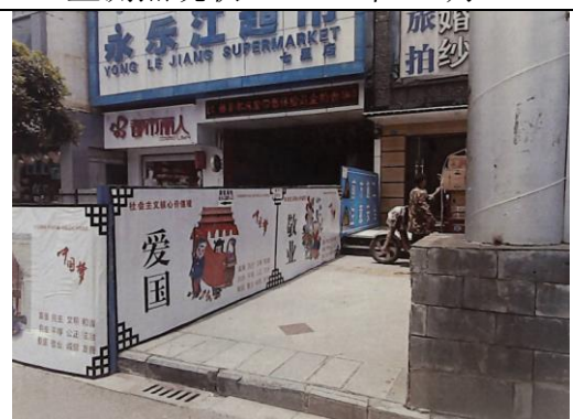
施工围栏 (2018年5月)
