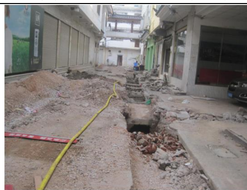
施工期开挖土石 (2018年5月)
