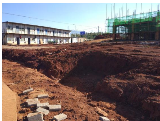
临时排水沟中部沉砂池
