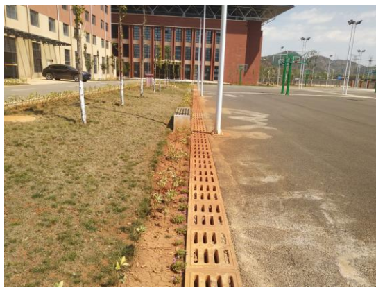
篮球运动场外围盖板排水沟
