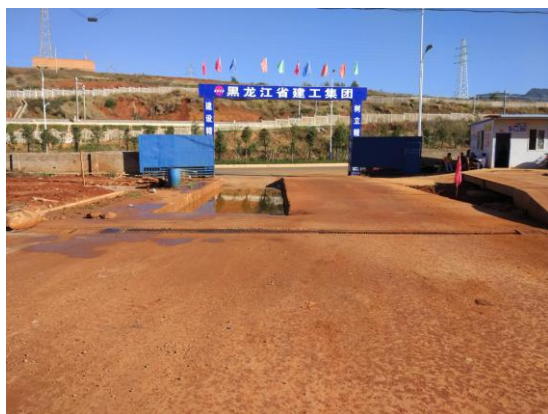
博大路侧施工出入口车辆清洗池
