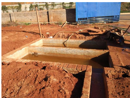
临时排水沟末端沉砂池
