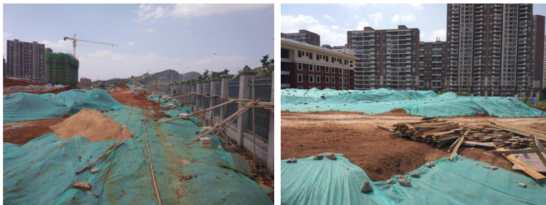
裸露面、临时堆存表土无纺布临时覆盖
