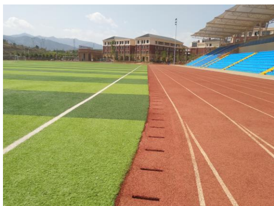
足球场运动场外围盖板排水暗沟
