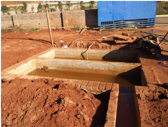
临时排水沟末端沉砂池
