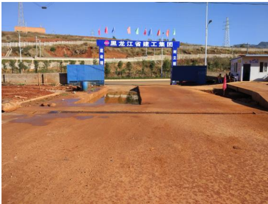
博大路侧施工出入口车辆清洗池
