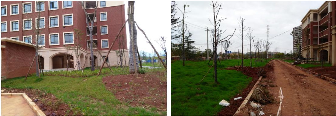
建构筑物及道路周边空地绿化
