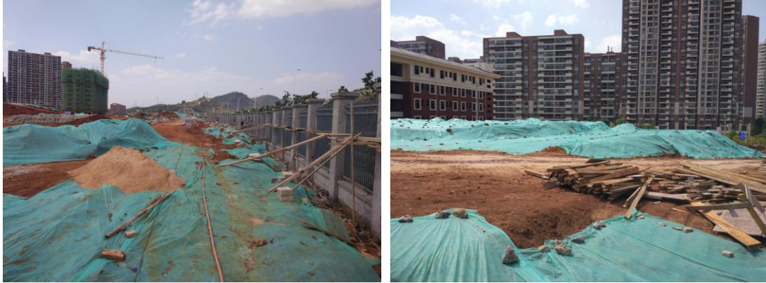
临时堆存表土及裸露面无纺布临时覆盖
