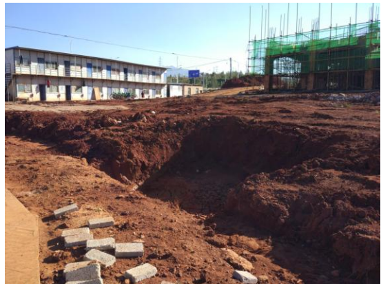
临时排水沟中部沉砂池
