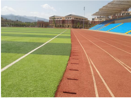
足球场运动场外围盖板排水暗沟
