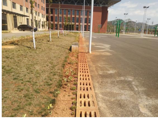
篮球运动场外围盖板排水沟
