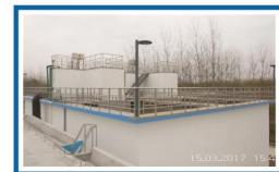
某污水处理厂中水厂的改进型BAF+反硝化滤池
