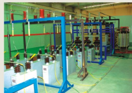
系统过电压1: 1试验设备一
