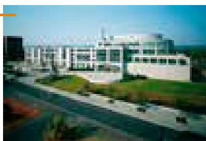
塑壳断路器用作建筑物的主配电的线路保护
